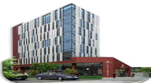
پروژه اداری تجاری وزراء ۲
