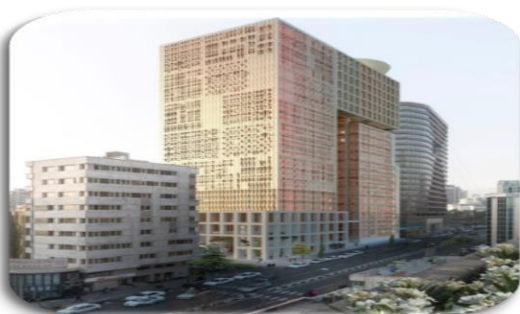
پروژه اداری تجاری نیلوفر مشهد
